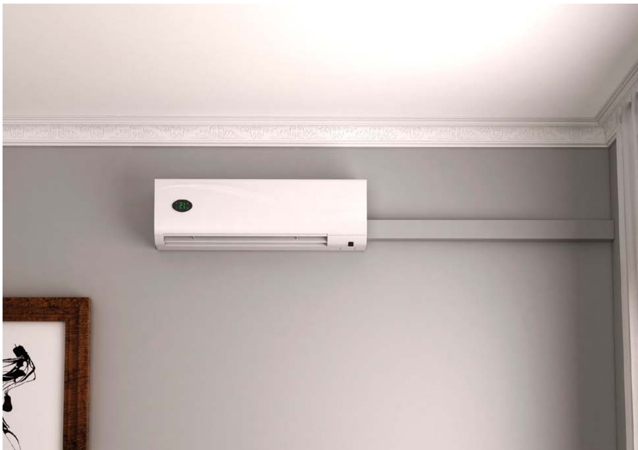
Rehabilitación de viviendas
