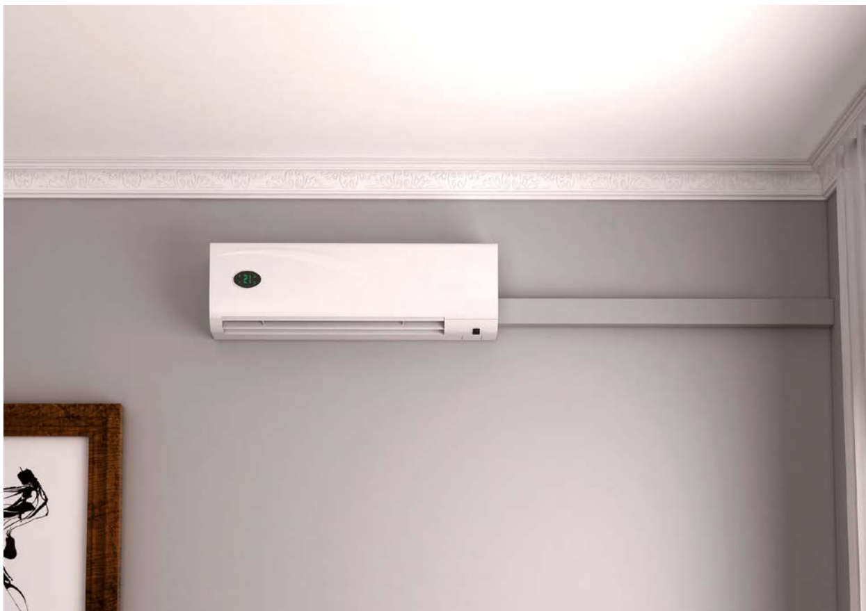
Rehabilitación de viviendas
