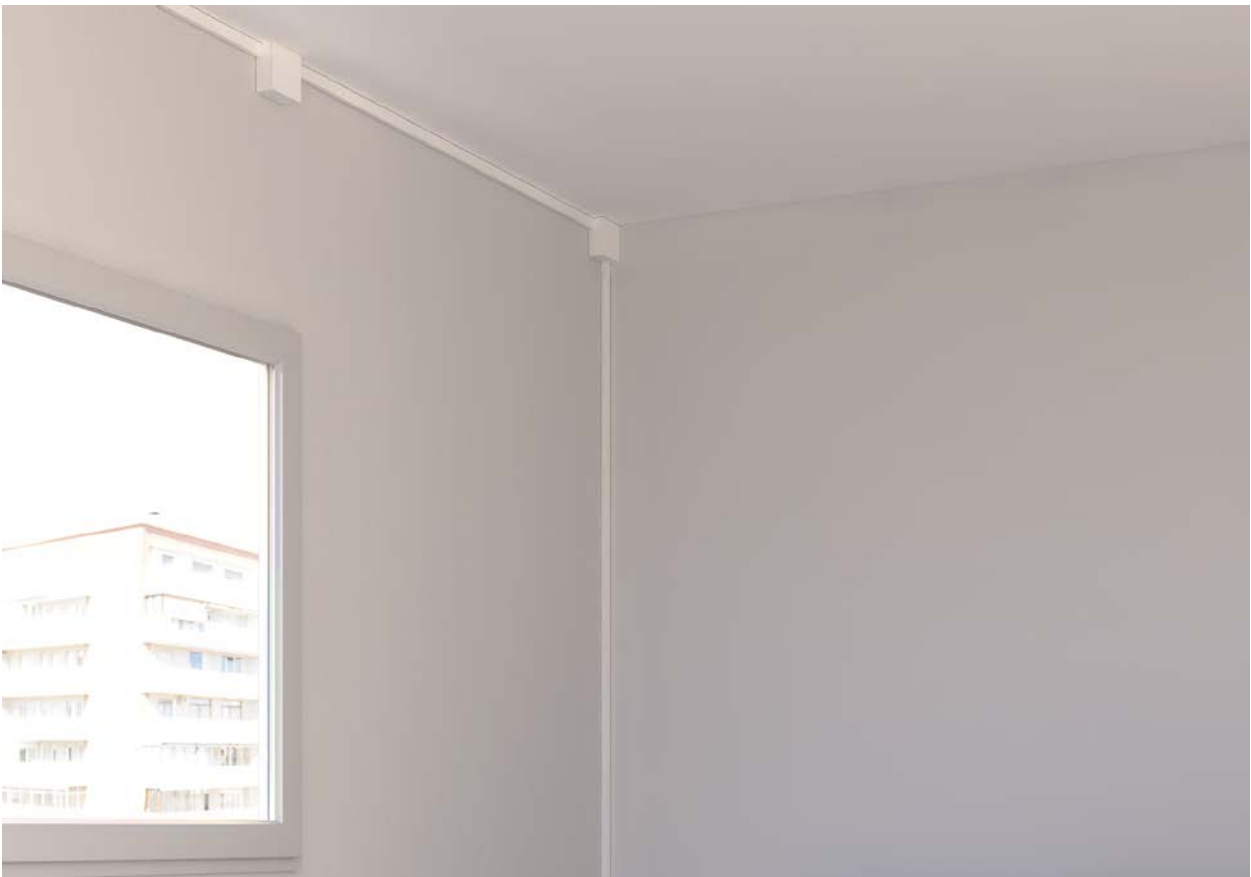
Rehabilitación de viviendas
