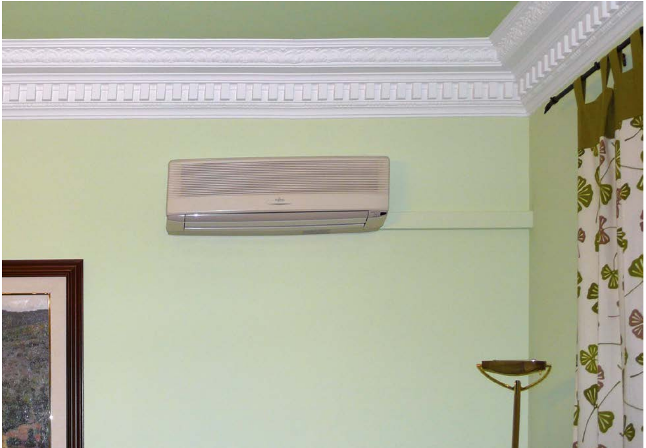
Rehabilitación de viviendas
