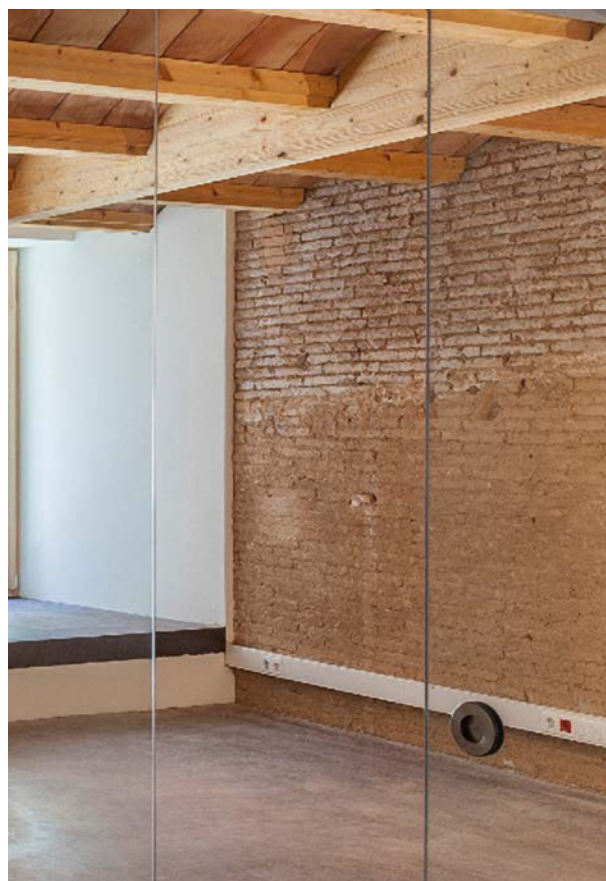
Espacios de trabajo: rehabilitación de oficina
