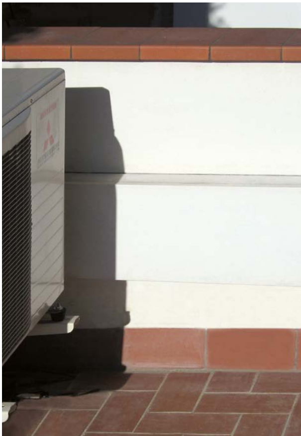
Réhabilitation de logement
